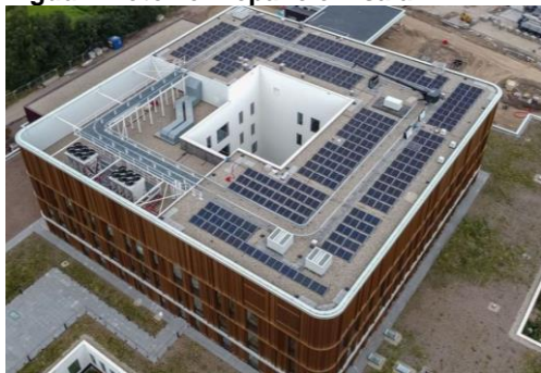
Figuur Foto zonnepanelen Isala
